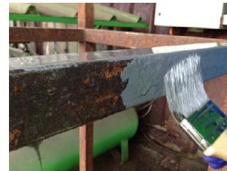
soluciones anti-corrosivas, junto con aislación térmica y protección mecánica/abrasiva, aplicable a tuberías, cañerías y estanques de hasta 110°C, y otros para calderas o similar en muy elevadas temperaturas.
