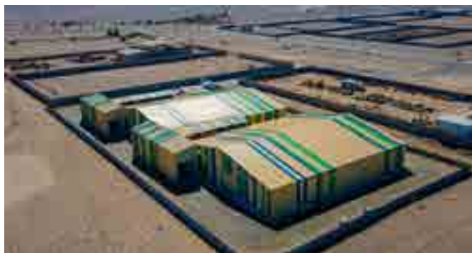
Nuevo Centro de Distribución Tarapacá de Cbb Cales
