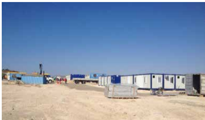
Instalación de faenas – Punta Zorro, Caldera 2018
