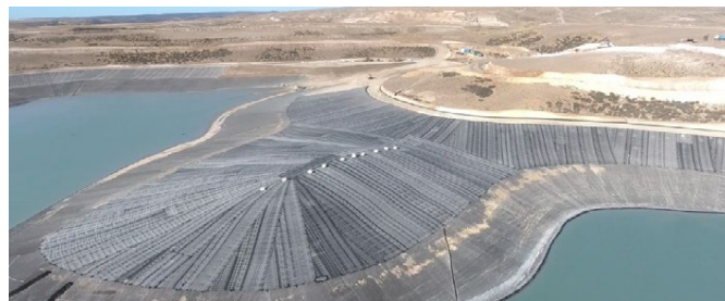
Reservorio de Relaves Impermeabilizado con COLETANCHE®
