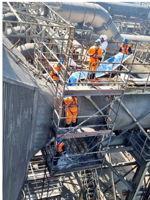
Junta de Expansión en Base a Telas
