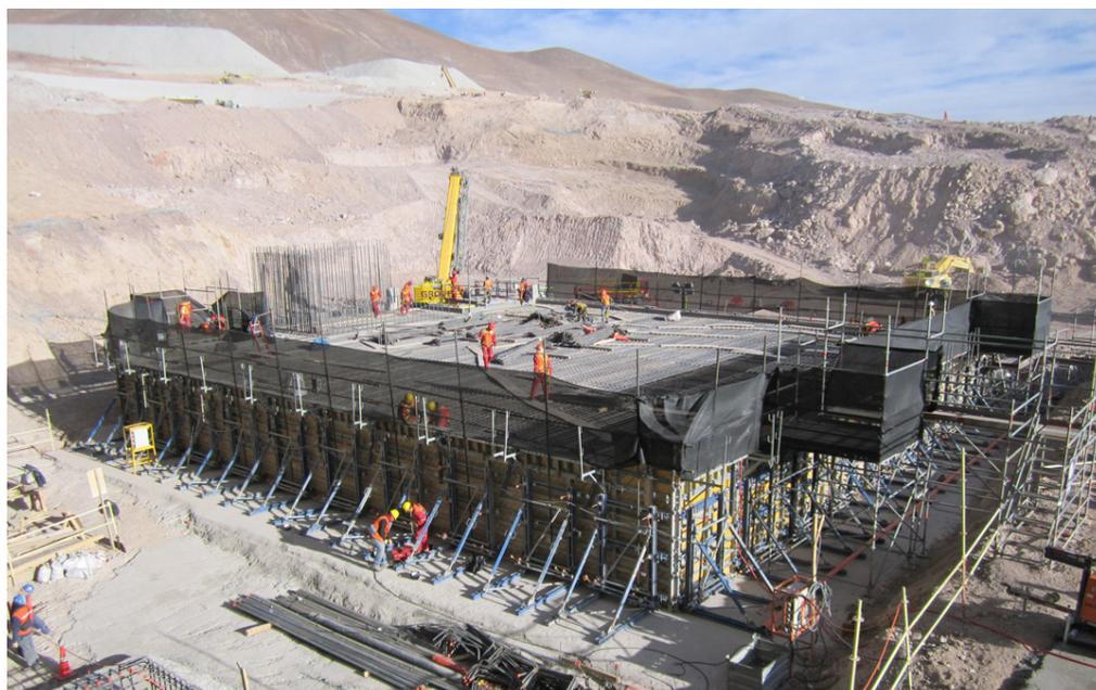
*migón de grandes volúmenes y con diseños de mezcla híper fluidos, vaciados a gran altura geográfica y con temperaturas de -20°. Pasando por sistemas livianos y que hacen prescindir el uso de equipo y de grúas en las áreas. Hasta sistemas de soporte de losas de gran espesor, con alta capacidad de carga por apoyo y con un sistema de andamio integrado a las torres de carga.*
