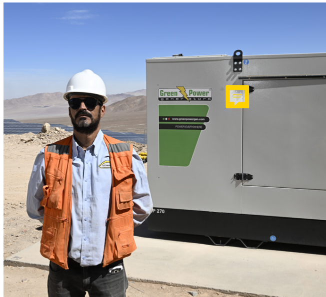
Jorge Orellana, Geólogo Residente de Tornosol, junto a proyecto de generación eléctrica híbrido fotovoltaico – gas licuado en Minera Tornosol
